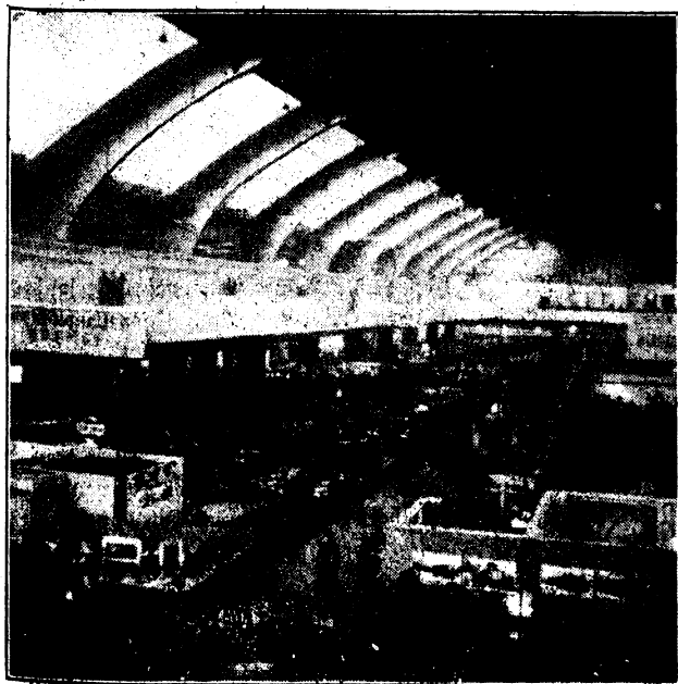
Blick in einen Teil der Halle 2.
