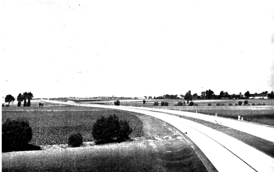
Bild 4. Blick auf die fertige Baustrecke 62 Liegnitz–Breslau, Sommer 1939
