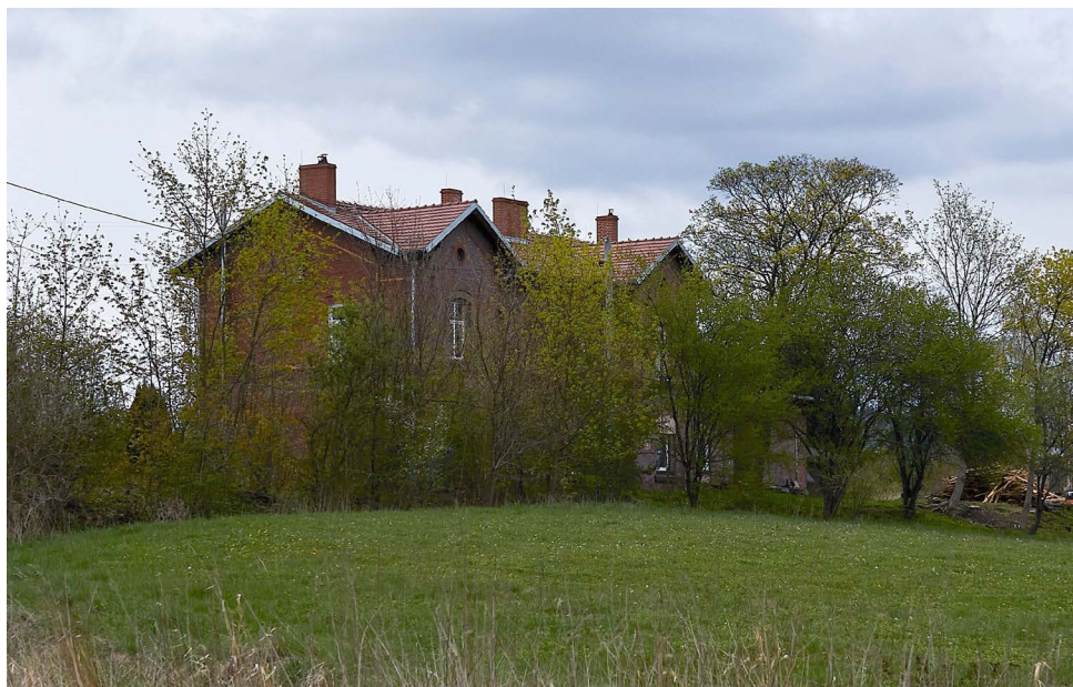
Il. 63. Dawny dworzec Kolei Doliny Zadnrny (Ziedertalbahn) w Chełmsku Śląskim. Linia łączyła Kamienną Górę przez Krzeszów i Chełmsko z Okrzeszynem. Powstała w ostatnich latach XIX w. z inicjatywy lokalnych przedsiębiorców, by ułatwić transport towarów. W okresie powojennym stopniowo ograniczano na niej ruch, by ostatecznie zlikwidować w końcu lat 80.
