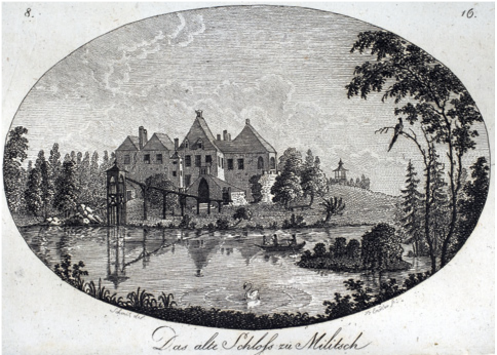
4. Dawny dwór biskupi, później siedziba Kurzbachów i Maltzanów, po wybudowaniu w 2. połowie XVIII w. nowego pałacu zwany „starym zamkiem”. Wyraźnie zaznaczone zrujnowane średniowieczne mury obronne, nadal otaczające renesansową, ale wykorzystującą wcześniejsze mury siedzibę, grafika z początku XIX w.
