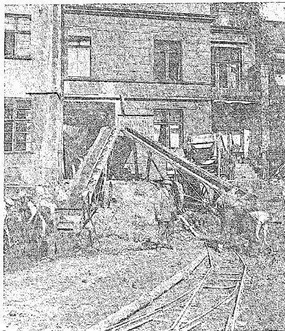
Neubau: Druckerei und Verlag Paul Steinke in Breslau Schichtstatten mit Förderband
