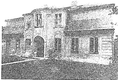
Altes Wohnhaus in Reppen, Weude des 15. Jahrhunderts Frankfurter Str. 5
