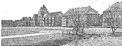
Wohnungsbauten der Elbinger Heimstätte
