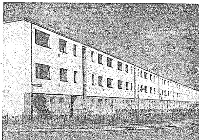
Gruppe 8: 2-stöckige Vierfamilienhäuser von Arch. Roedke, Frankfurt a. M. Von Südosten gesehen. Untergeschoß ebenerdig, darüber 2 Wohngeschosse*
