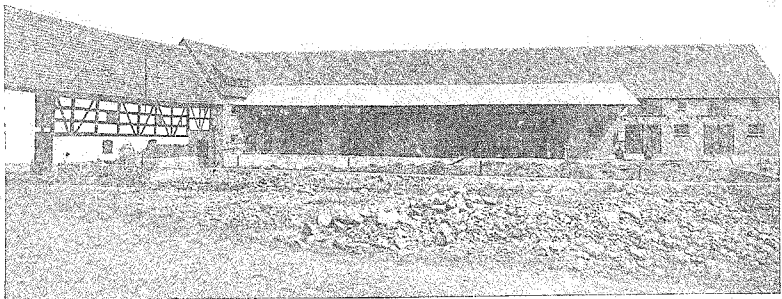
Abbildung 4: Verbreiterung der Scheune durch ein freitragendes Dach an der Hofseite, unter welchem der Erntewagen, die Strohprelle und die Lokomotive hintereinander aufgestellt werden können. In der Erntezeit lassen sich auch hier eine größere Anzahl Gespanne zum Schutz gegen Regen unterstellen
