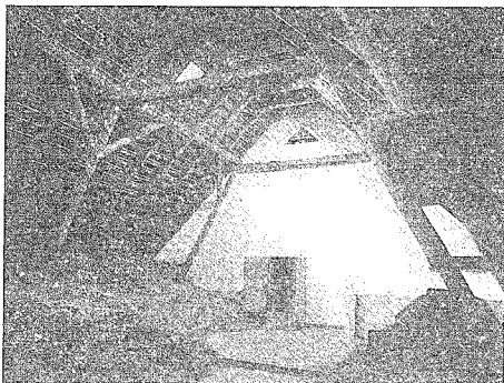
Abbildung 7: Verwendung von Rundhölzern bei der Dachkonstruktion für Stiele, Streben und Kopfbänder; die Zangen werden aus aufgetrennten Rundhölzern gewonnen. Nur die Sparren und Rähme sind aus Kanthölzern hergestellt!
