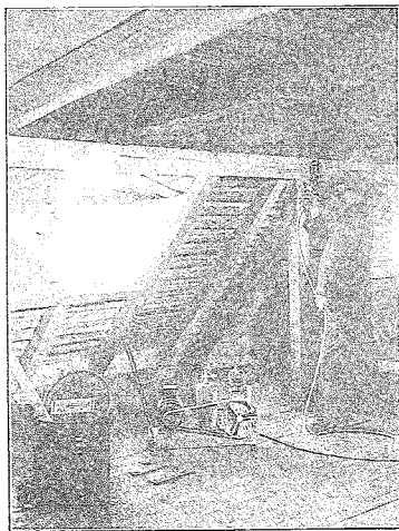
Abb. 5: Brandschutz-Imprägnierung eines Dachstuhl mit einem Brandschutzmittel (Werkaufnahme)
