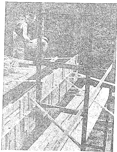
Wasserbauamtsdienstgebäude Gleiwitz OS. Die holzsparrende Leiterrüstung. Diese Rüstung hat den Vorteil erheblicher Holzersparnis gegenüber der Stangenrüstung. Näheres hierüber im Aufsatz
