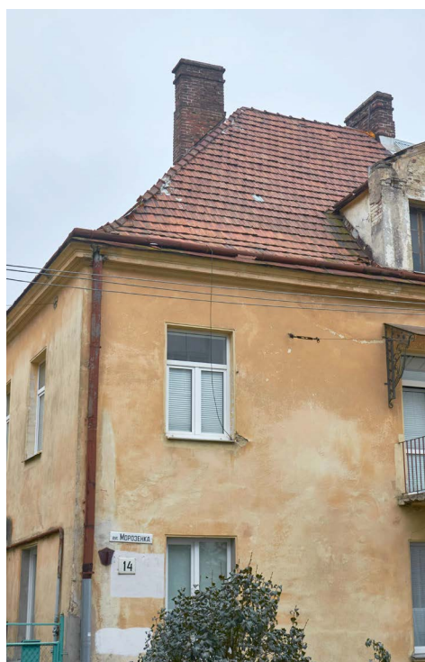
Il. 15. Dom, w którym przed wojną mieszkał Stefan Ingłot. Lwów, ul. H. Dembińskiego 14 (grudzień 1939) (obecnie ul. S. Morozenki 14)
