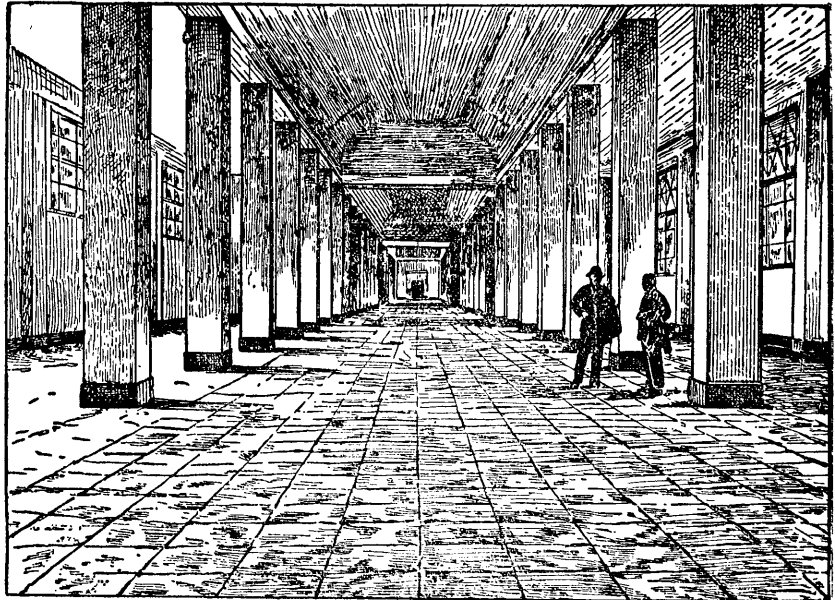
Hala Centralna PWK (tereny wschodnie) o powierzchni 7.200 m. kw., w której została pomieszczona wystawa przemysłów: papirniczego, papirniczo-przetwórczego, graficznego i chemicznego.
