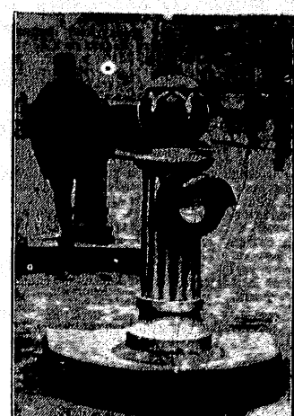
Na bulwarach w Paryżu, gdzie panuje bardzo silny ruch pojazdów mechanicznych, ustawiono ostatnio nowe sygnały do regulacji ruchu. W przeciwieństwie do starych sygnałów, które wisiły na znacznej wysokości i w skutek tego przy większym zagęszczeniu pojazdów były słabo widoczne, nowe sygnały są umieszczone nisko nad jezdnią, co ma te zalety, że łatwo można je zauważyć.
