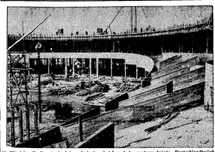
W Witzleben-Berlin stanie już w jesieni największa hala sportowa świata „Deutschlandhalle”. Zdjęcie przedstawia odcinek hali znajdujący się w budowie.
