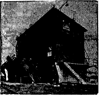
Wywrotki węglowe w porcie górnym kopalni „Polskarob” (ekspozytura Górnośląskiego Koncernu Węglowego „Robur” w Katowicach) jednym chwytym wypracują i przeladują cały wagon węgla.
