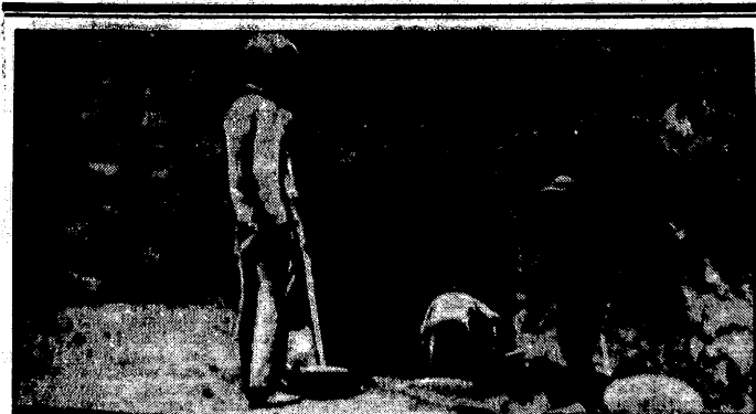
W związku z możliwością bliskiego nalotu włoskich samolotów bombowych na stolicę Abizyjni, Addis Abebe, władze abizyjskie zarządziły budowę schronów, przy których prace wykonywane w szybkim tempie. W większości wypadków jako schrony budowane są ganki podziemne w terenowych wyniosłościach.
