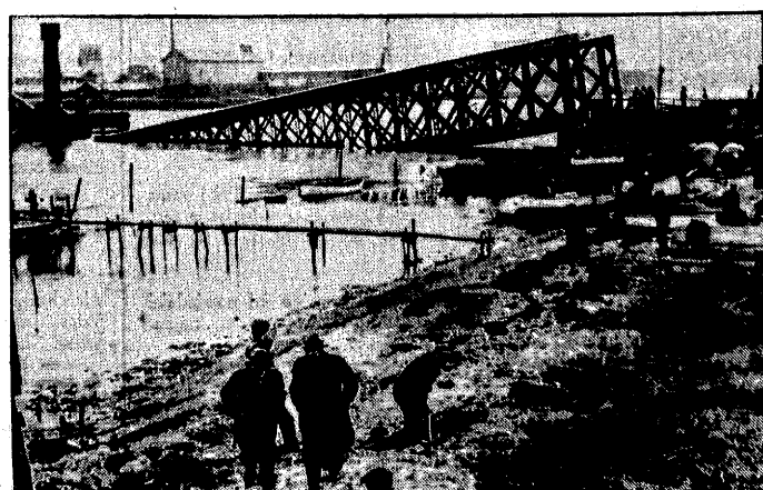
W cieśninie Masned stałach parowiec angielski na filarach swoich, wobec czego ten załamał się i pogrzążył w wodę, jak to widzimy na naszym zdjęciu. Wskutek zniszczenia mostu został przerwany na dłuższy czas ruch towarowy między Niemcami i Danją, który głównie kierował się tą trasą z Warnemünde do Gledaer.
