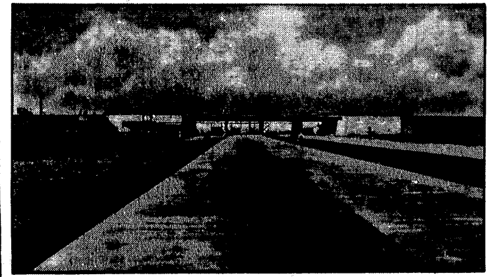
W tryb dlnach oddana zostanie do użytku nowowubudowana autostrada łącząca Halle z Lipskiem. Na zdjęciu odcinek omawianej ssozy przedcietej będący w budowie autostradą Berlina — Meccachjum.
