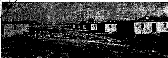
Kolonia tanich domków dla bezdomnych w Tarnowskich Górach, przy ulicy Gliwickiej, wykonanych z inicyjatywy Pana Wojewody, według najnowszego syst. z płyt „SOLOMIT“. Informacje u firmy „Solomit“ Katowice, ul. Mickiewicza 38, telefon nr. 302-08.
