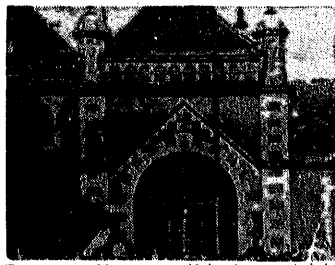
Fragment głównego wejścia dworca kolejowego w Gdańsku.
