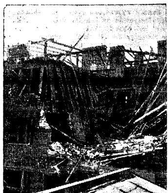
Ubiegłej nocy wydarzyła się w Warszawie, (o czym donosiliśmy wczoraj) przy ul. Litewskiej nr 10 poważna katastrofa budowlana. Mianowicie runęło z łoskotem 3 i 4 piętro nowo wybudowanego gmachu, na szczęście jeszcze nie zamieszkałego. Katastrofa spowodowała również poważne uszkodzenia w sąsiedniej zamieszkałej kamienicy, pod nr 12. Oto rzut oka na ruiny nowego gmachu.
