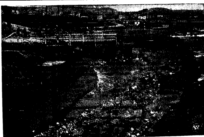
Nienotowana dotąd ulewa nawiedziła onegdaj Gdynię, powodując katastrofalne następstwa. Zdjęcie przedstawia fragment zniszczenia, wywołanego przez rzekę Kaczą w okolicy gdynińskiej.
