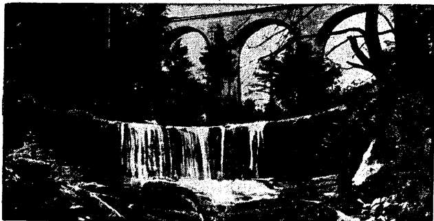
Wspaniały wiadukt kolejowy na linii Wisła — Głębcze nad wodospadem w Łabajowie.
