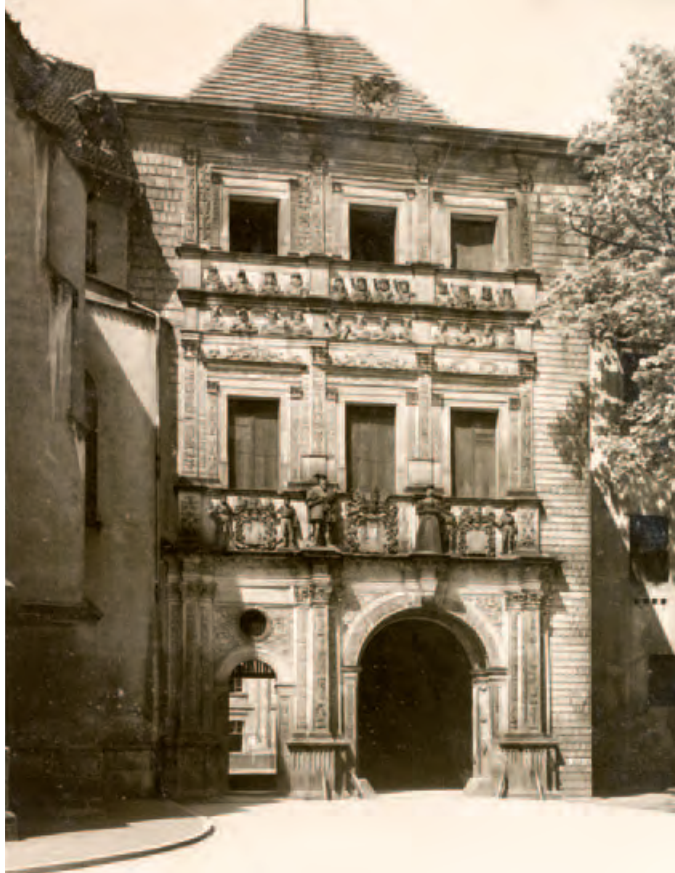
3. Brama wjazdowa zamku w Brzegu, fot. H. Klette, ok. 1940; OZG Inw. Fot. 2781
