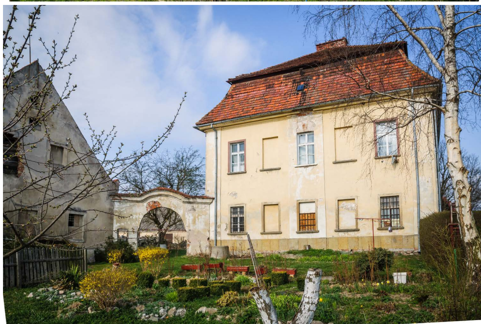
Fot. 17–18. Dwór w Miskowicach, XVIII w., dach mansardowy z wtórnie wbudowanymi lukarnami (XXI w.). Element założenia, w którym budynki gospodarcze z dworem połączone były dwiema bramami wjazdowymi
