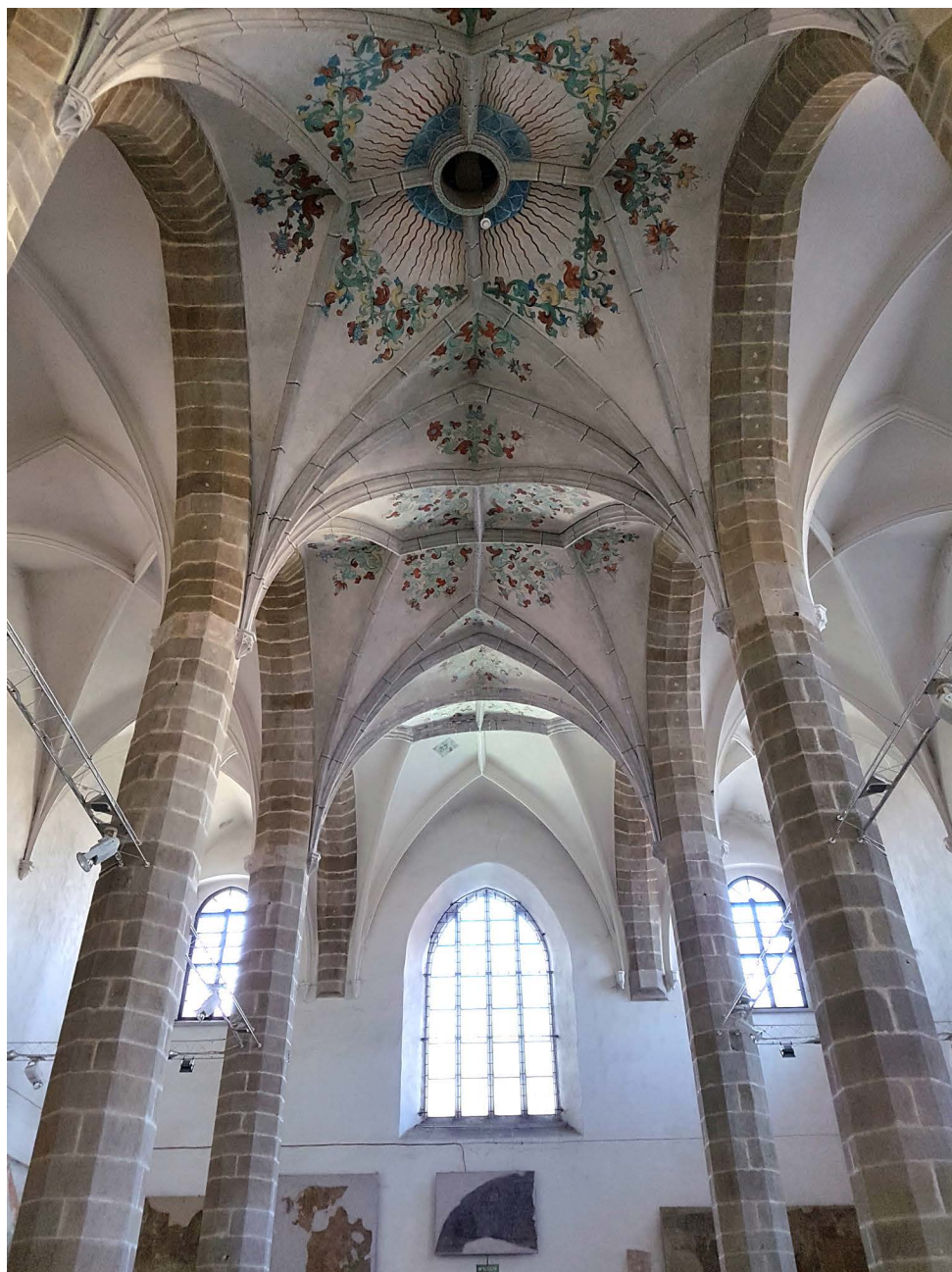
Il. 5. Gotyckie sklepienia klasztornej kościoła pw. Panny Marii Wniebowziętej i św. Andrzeja Apostoła w Jarworze, obecnie Muzeum. Fot. Arkadiusz Muła
