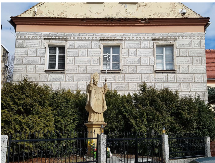
Il. 10. Renesansowa dekoracja sgraffitowa elewacji budynku plebanii przy kościele św. Marcina. Fot. Arkadiusz Muła
