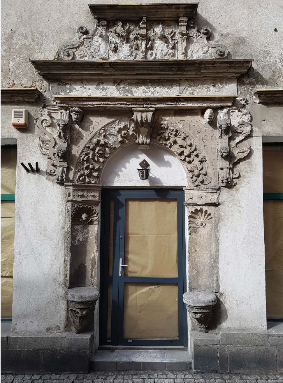
Il. 16. Manierystyczny portal kamienicy przy ul. Chrobrego 4, ok. 1560 r. Fot. Arkadiusz Muła
