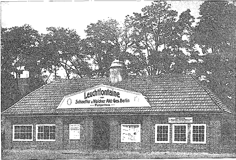
Pumpenhaus von Schaeffer & Walcker Akt.-Ges. in Berlin
